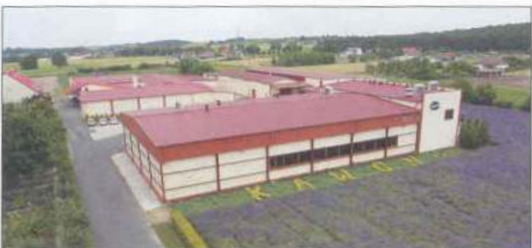
Stan obecny już po wybudowaniu nowej wytwórni i rozbudowie budynku administracyjno-laboratoryjnego
